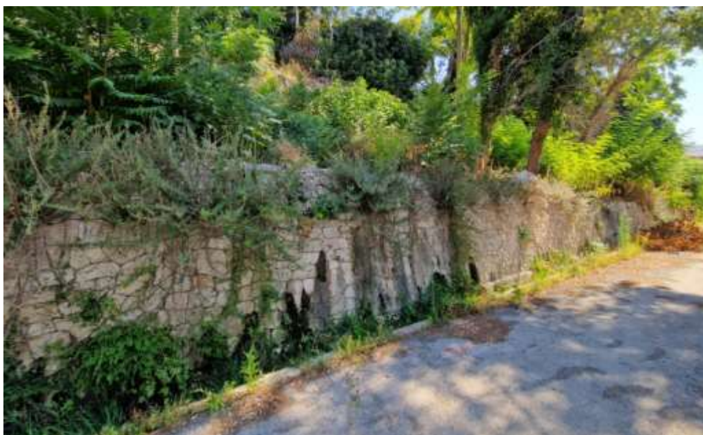
Figura 6 - Umidità e infiltrazioni di acqua sul muro di contenimento del terrapieno
