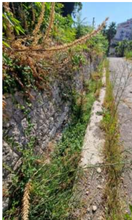
Figura 5 - Canale di scolo delle acque del terrapieno
