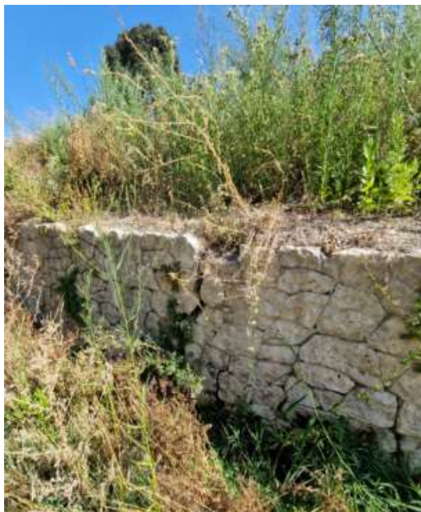
Figura 4 - Lesione del muro di contenimento del pendio
